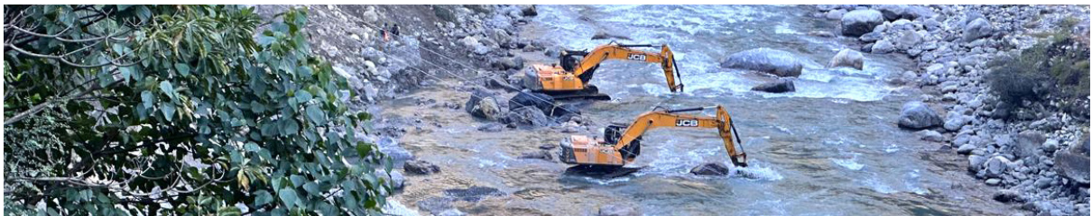
बाँधस्थलको निर्माण कार्य
