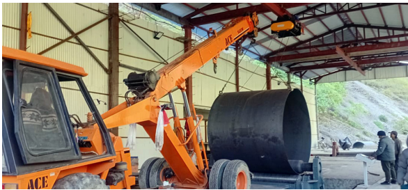
पेनस्टक पाईप निर्माण कार्य
